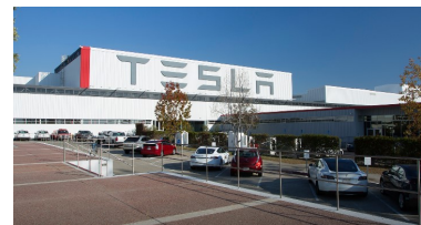
Tesla Factory (Tesla 社 HP より)
