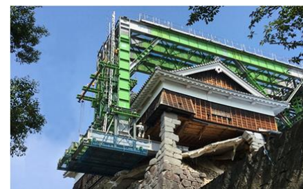
熊本城 飯田丸五階櫓（やぐら） (株)大林組 HPより
